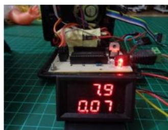
Gambar 21. Pengujian baterai tanpa beban
